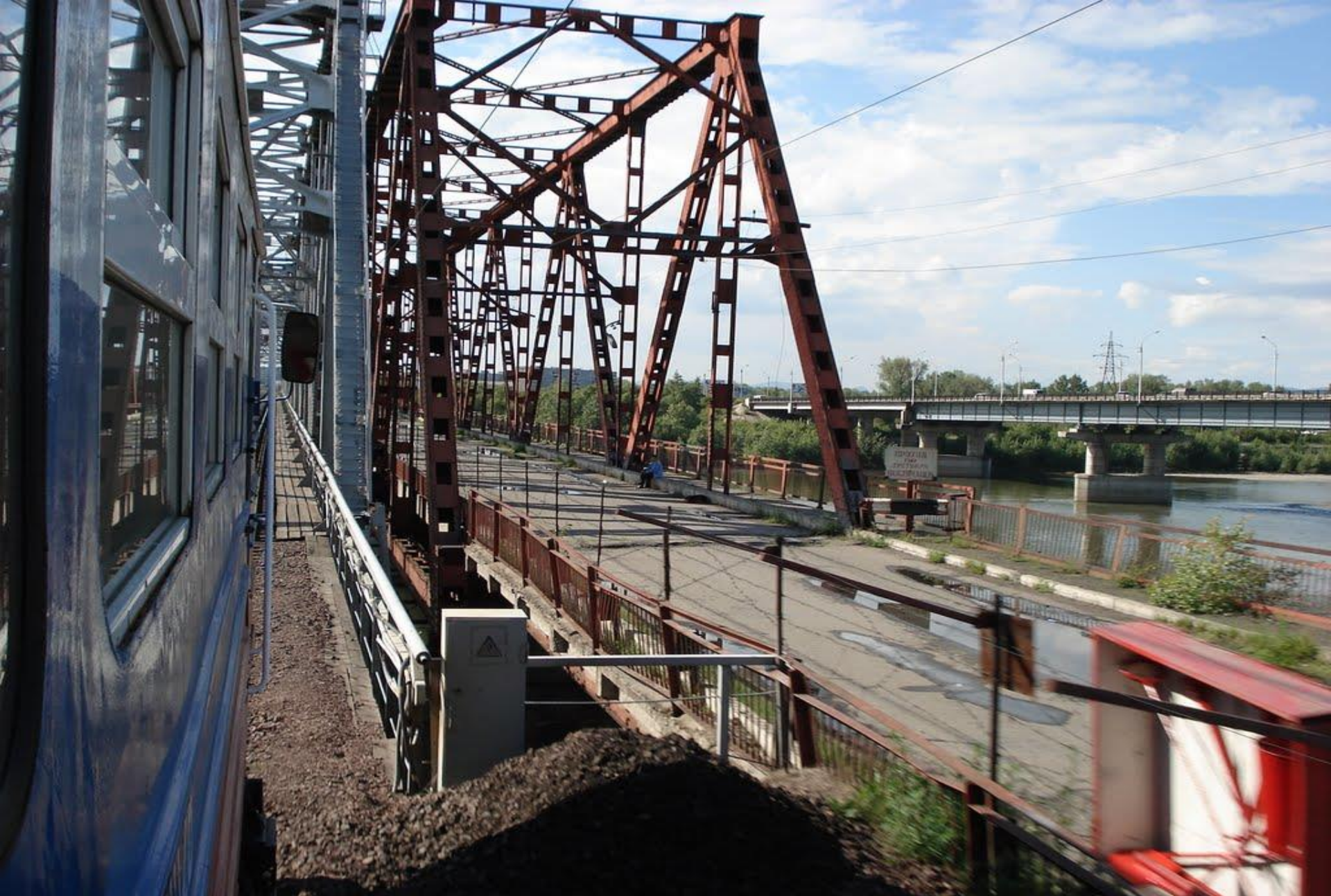
Мост через реку Абакан.
